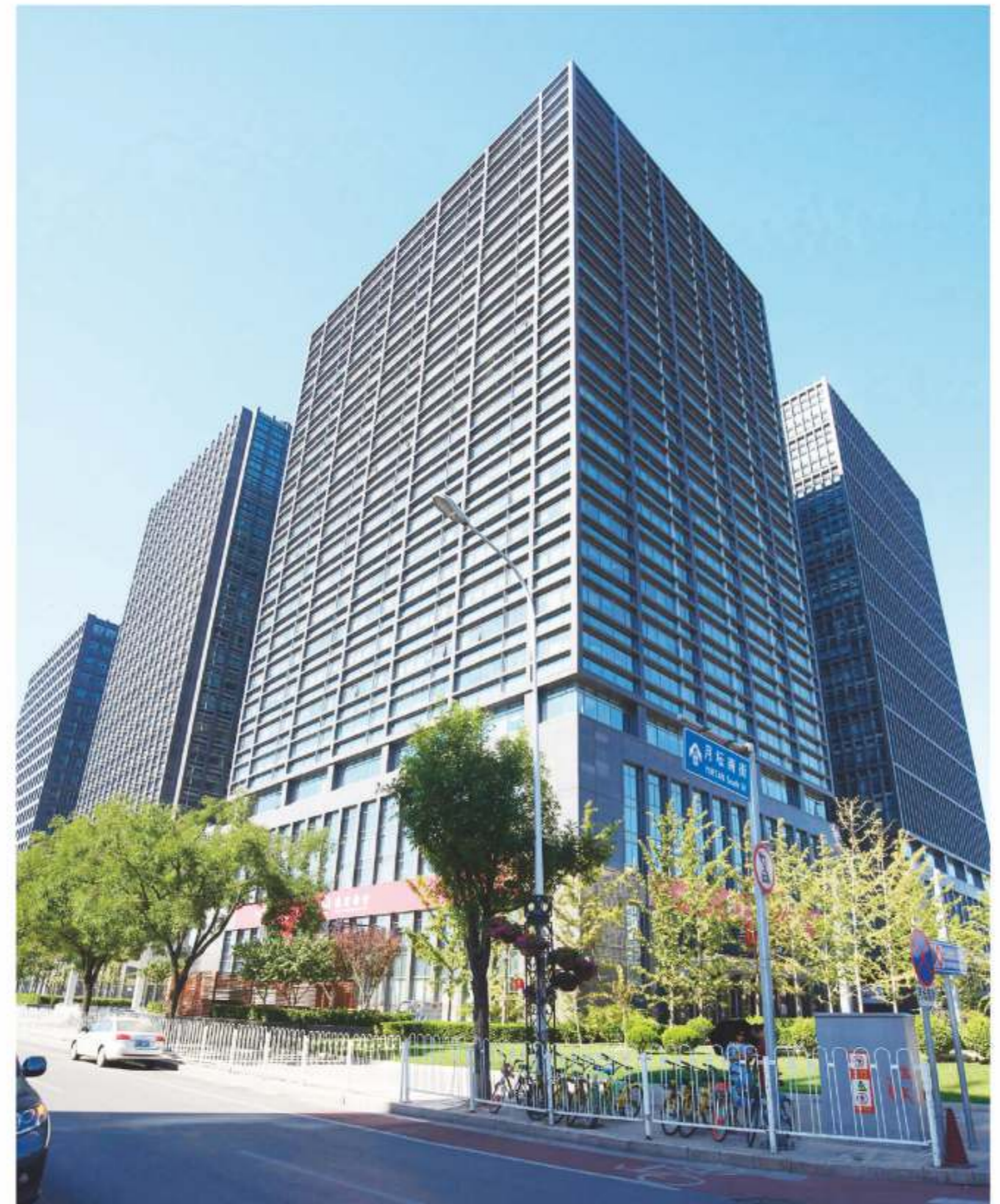
China Merchants Bank - Beijing Branch 北京招商银行
